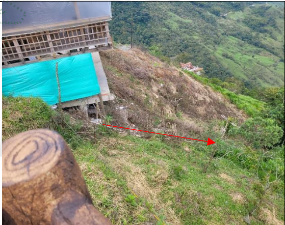
Imagen 4. Tubería que presuntamente transporta las ARD
