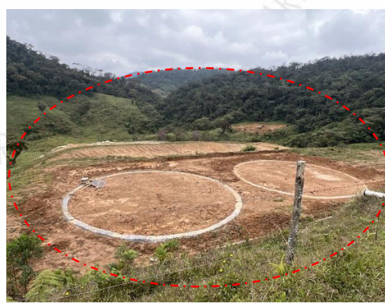
Figura 8. Tanques para el almacenamiento y manejo de aguas lluvias
