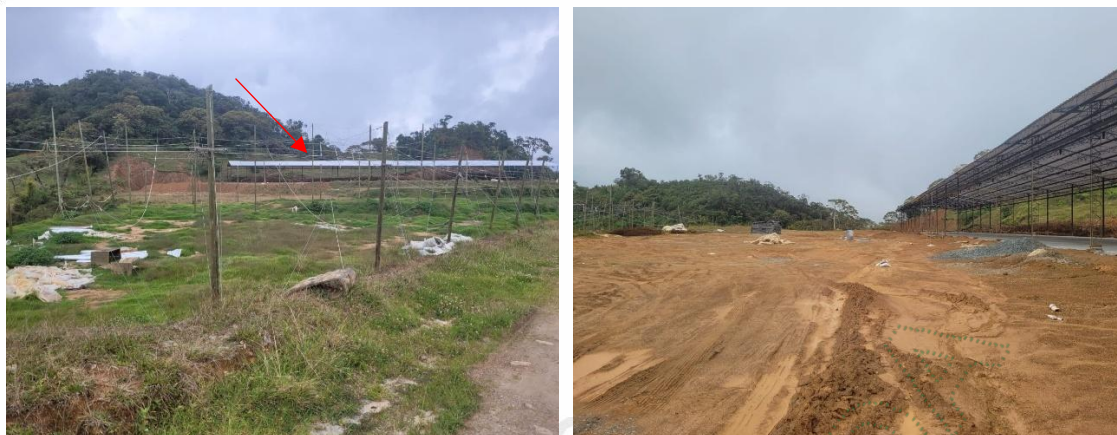
Figura 9. Construcción y adecuación del segundo galpón
