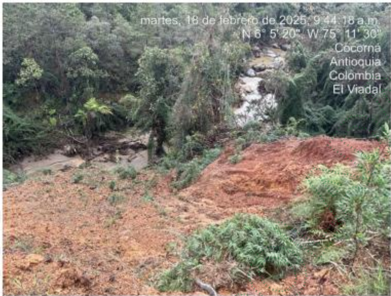
Imagen 6. Depositó material sobre la margen izquierda de la quebrada La Trinidad
