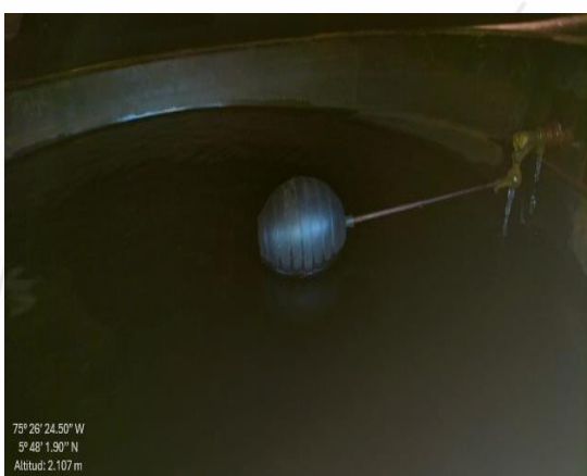
Imagen 5 y 6. Sistema de almacenamiento de agua instalado en el predio, con dispositivo de control de flujo.
