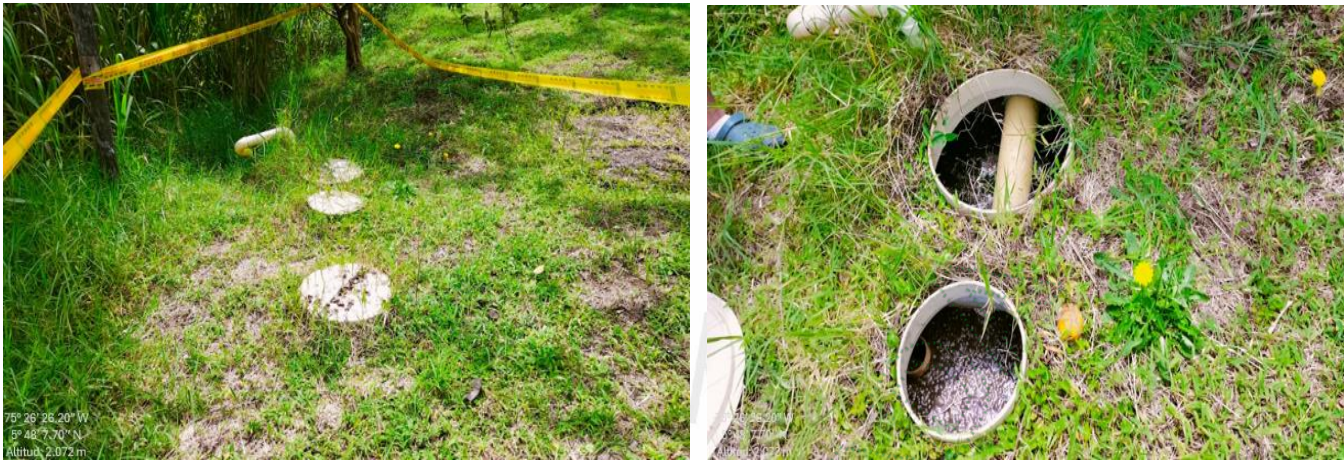
Imagen 10 y 11. Sistema de tratamiento de aguas residuales domésticas instalado en el predio.
