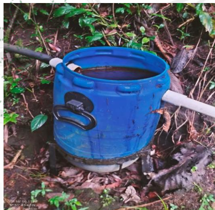
Imagen 3 y 4. Implementación de obra de control de caudal en la fuente hídrica La Tablaza.
