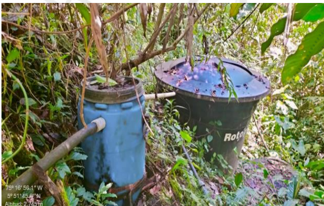
Imagen 3 y 4. Implementación de obra de control de caudal en la fuente hídrica La Tablaza.
