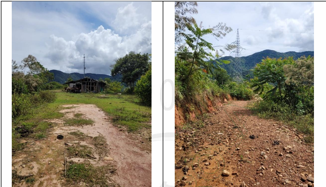
Imagen 15. Estado vivienda y torre 003 de la línea de transmisión de la CH San Miguel, evidenciado en la visita técnica de control y seguimiento (25 de febrero de 2025)
