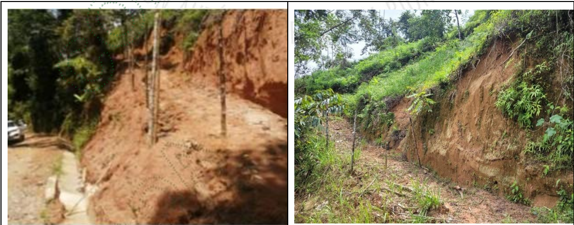
Imagen 22. Estado punto de finalización desde la vía sin permiso paralela a casa de máquinas,
