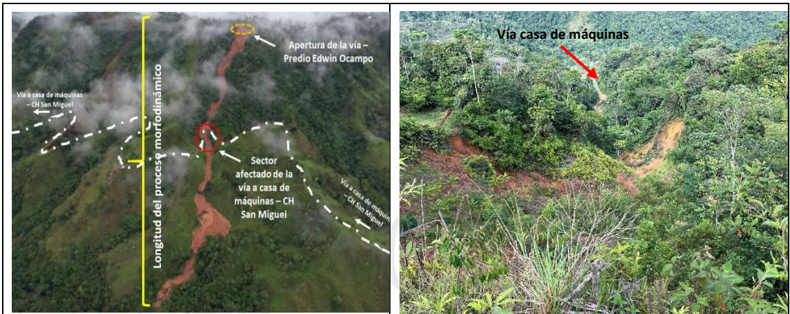
Imagen 3. Estado Parte superior del deslizamiento – Corte vertical en vía evidenciado en la visita técnica de atención a queja ambiental (30 de agosto de 2022)
