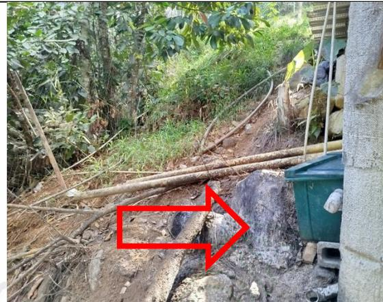
**Figura 8.** Descarga de trampa de grasa del restaurante a campo abierto.
