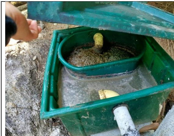
Figura 7. Trampa de grasa implementada en el restaurante.
