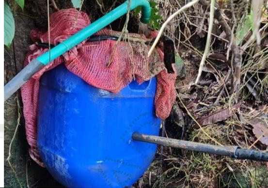
**Imagen2.** Tanque Sedimentador. Cornare 2025
