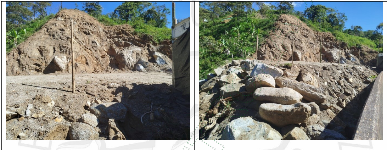
Figuras 1 y 2. Actividades de movimiento de tierras en el inmueble de interés.
