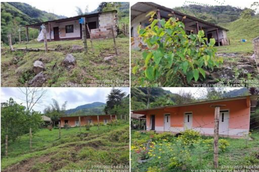
Casas que dieron origen a la queja y que ya no están generando vertimientos.
