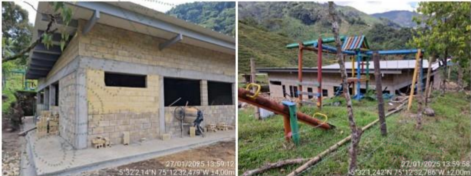
Escuela en construcción y a punto de ser terminada.
