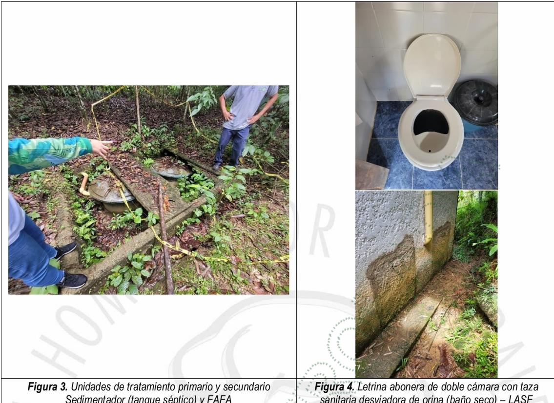
**Figura 3.** Unidades de tratamiento primario y secundario Sedimentador (tanque séptico) y FFAF
