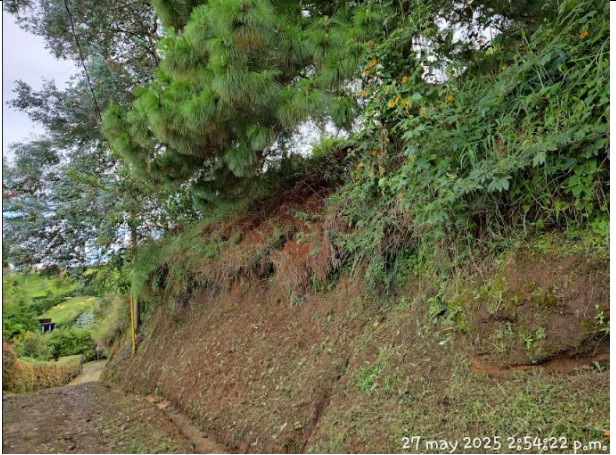
Talud de alta pendiente
