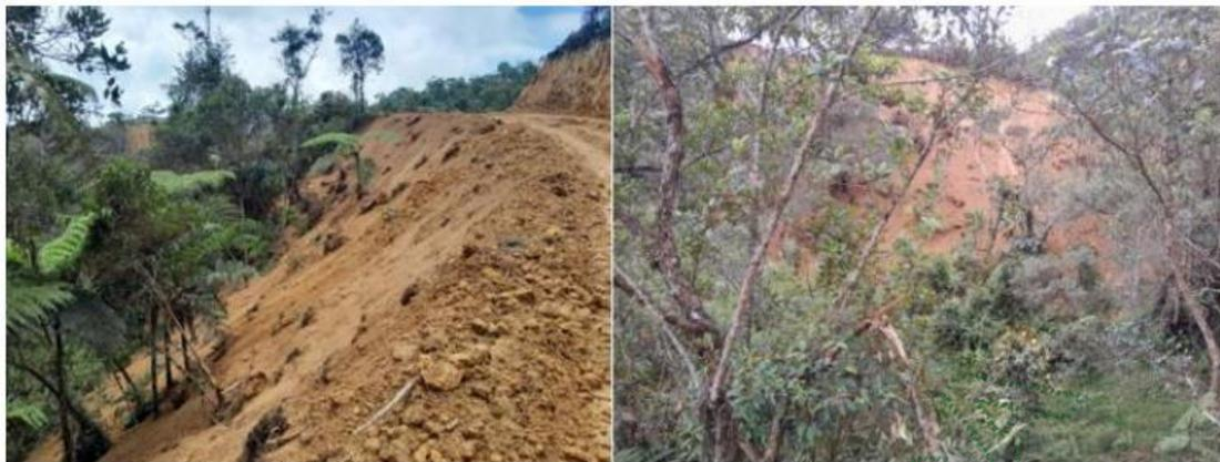
**Figura 3.** Mala disposición de tierra en laderas del predio permitiendo sedimentación de fuente de agua
