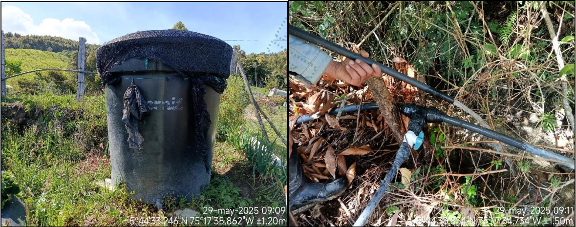
Tanque de almacenamiento
