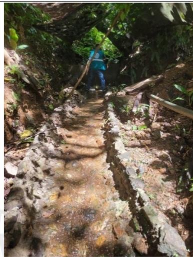
**Imagen 26.** Canal enrocado en concreto sobre el cauce de la Quebrada sin nombre
