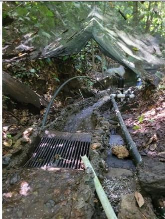
**Imagen 27.** Canal enrocado en concreto sobre el cauce de la Quebrada sin nombre
