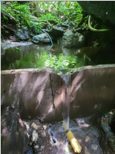
**Imagen 25.** Obra de captación para uso riego de prados y jardines ubicada en un sitio con coordenadas 74°51'11.23\"W 05°55'12.24\"N 347msnm
