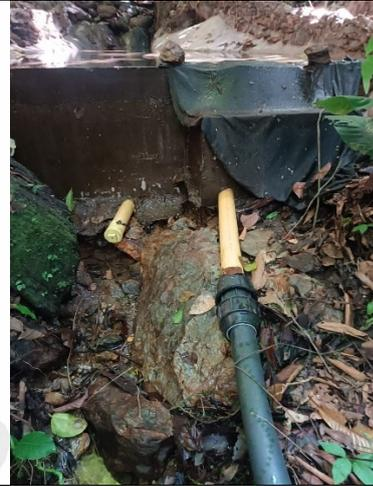
**Imagen 19 y 20.** Obra de captación para uso doméstico ubicada en un sitio con coordenadas 74°51'12.02"W 05°55'15.22"N 356 msnm
