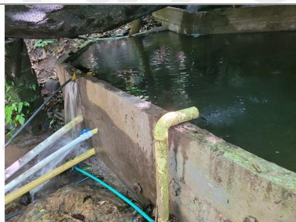
**Imagen 30.** Salida tuberías para el aprovechamiento
