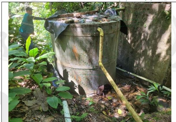
**Imagen 24.** Tanque de almacenamiento N°2 en fibra de vidrio
