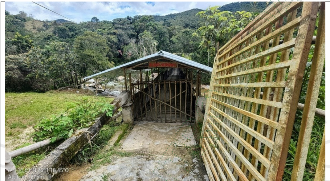
Imagen6. Acceso a la estructura sobre el río dormilón. Cornare 2025
