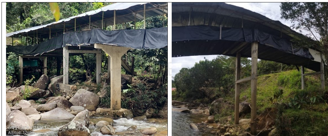
Imágenes 4y5. Columnas en concreto que soporta la estructura de intervención. Cornare 2025
