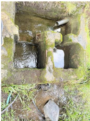
Figura 6. Obra de distribución
