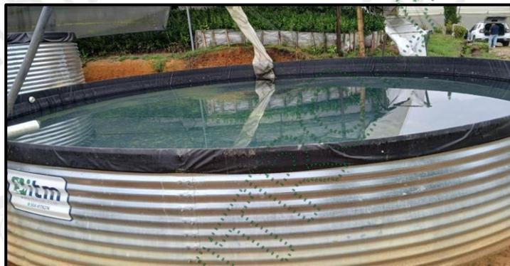
Imagen 8: Tanques de recolección de aguas lluvias
