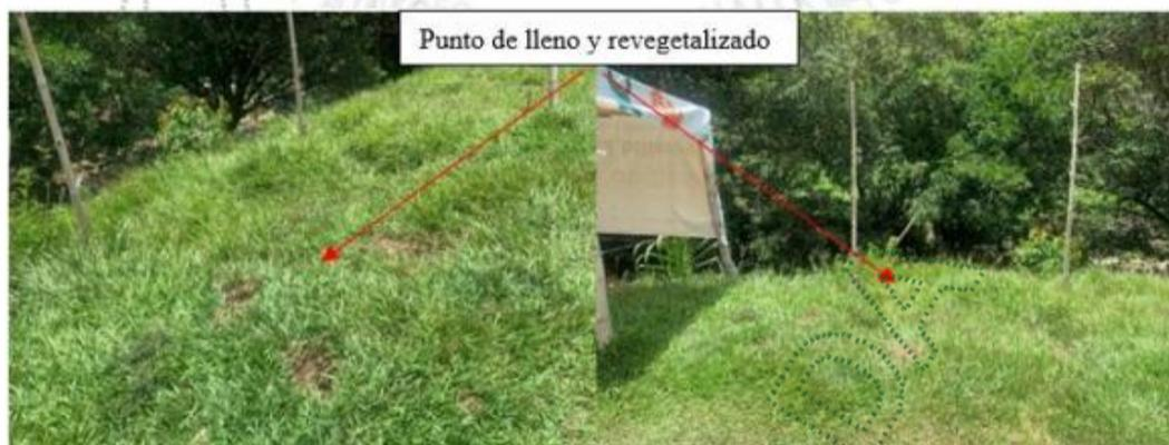
**Figura 2.** Área de socavación con lleno y revegetalizada con gramíneas
