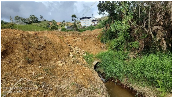
Imagen 8. Punto final canalización fuente hídrica denominada “sin nombre”. Cornare 2025.
