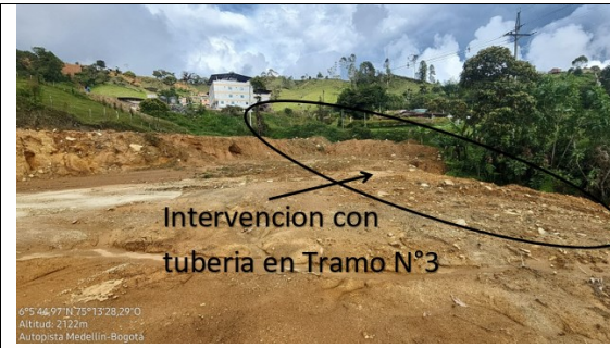
Imagen 7. Intervención Tramo N°3 en canalización fuente hídrica denominada “sin nombre”. Cornare 2025.
