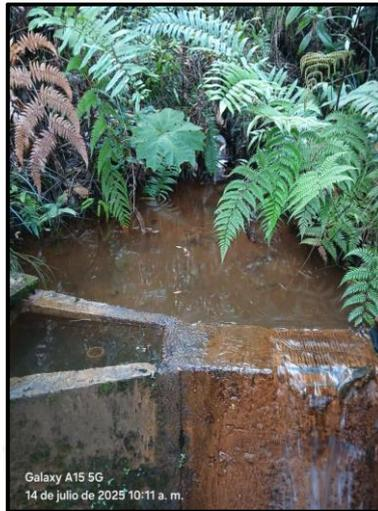
Imagen 1: Estructura de captación hallada en la fuente alterna “El Dragal 1” mediante la cual, anteriormente, se captaba el recurso
