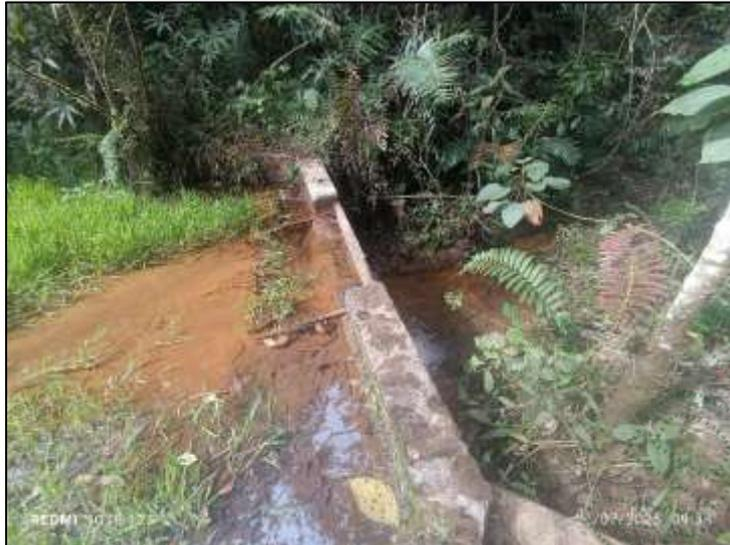
Figura 2. Rejilla implementada para el control de caudal
