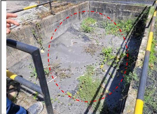
**Imagen 12.** Sistema de tratamiento de aguas residuales domésticas, con presencia de sedimentos y material de arrastre
