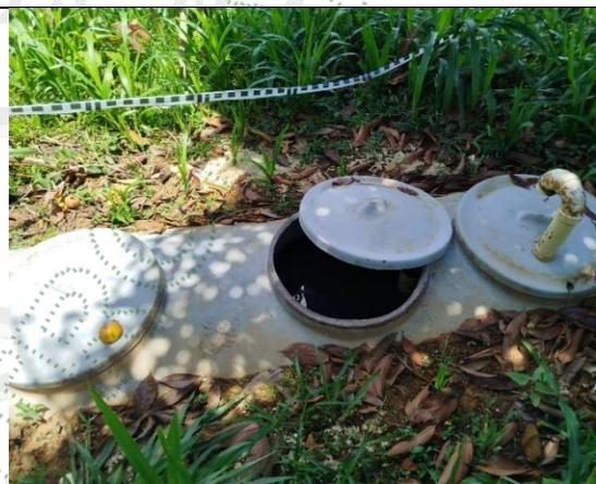
**Figura 2.** Sistema de tratamiento de aguas residuales domésticas (Pozo séptico y FAFA)
