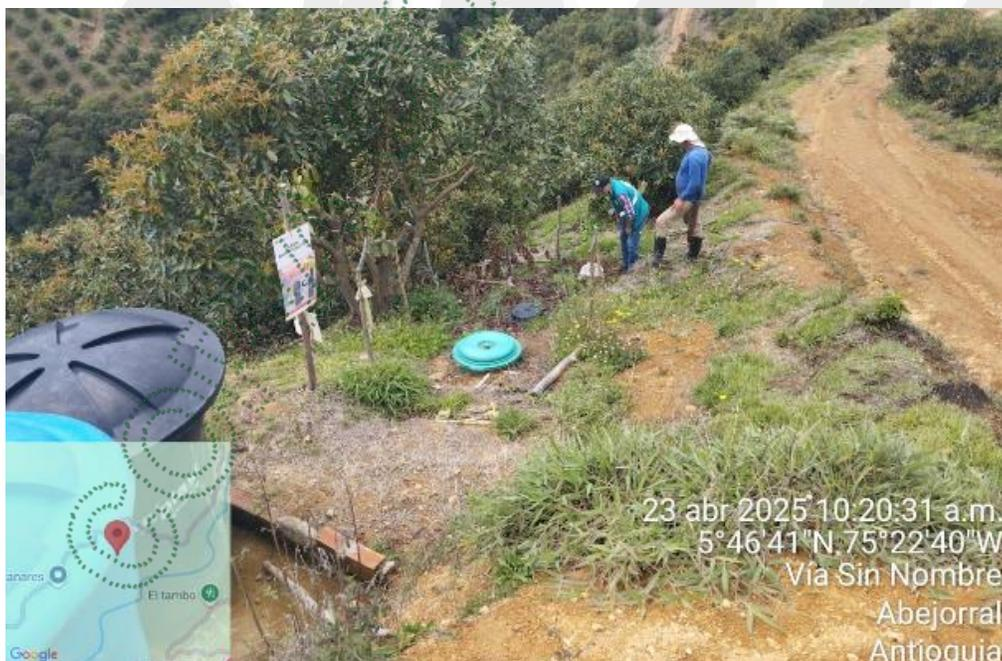
Pozo de desactivación evidenciado en campo con desactivador de 55 litros y almacenamiento de 20 litros
