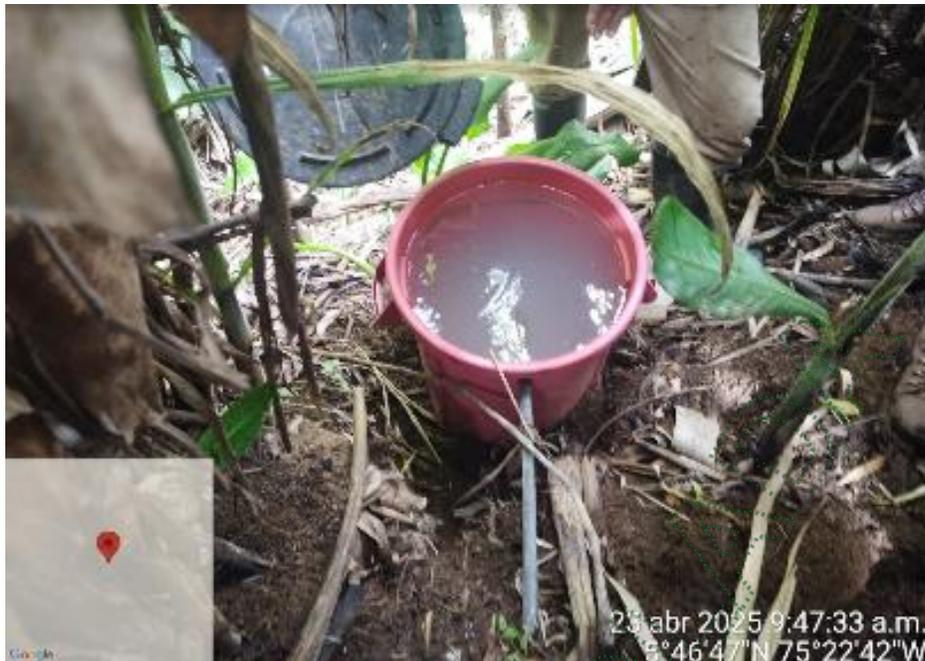
**Almacenamiento de 55 litros después del pozo de desactivación área de inmersión conectado a zona de lavado y baños de empleados, difiere con lo planteado por la empresa Agrogreen SA**
