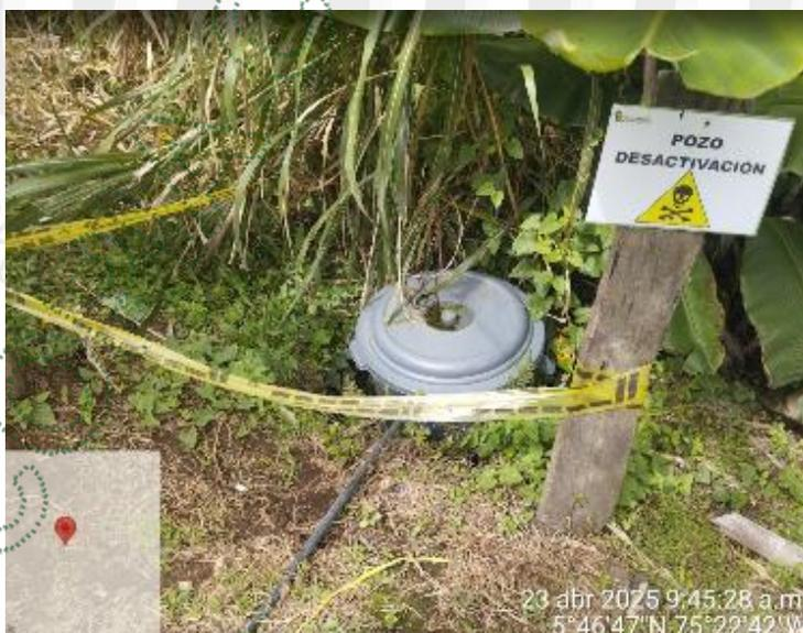
**Pozo de desactivación de 55 litros en área de inmersión conectado a zona de lavado y baños de empleados**
