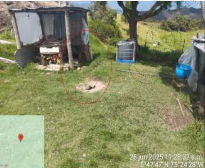
Sumidero casa principal
