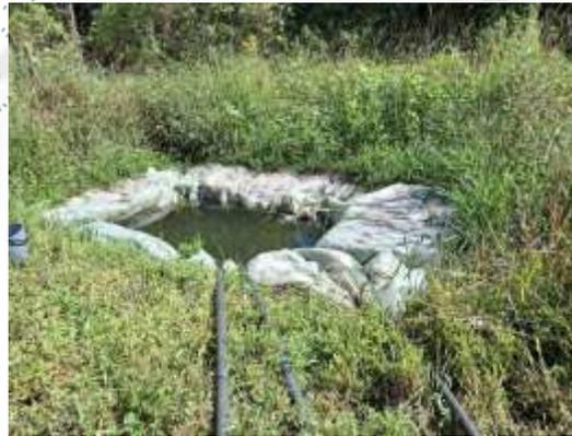
**Imagen 2.** Pozo de succión impermeabilizado
