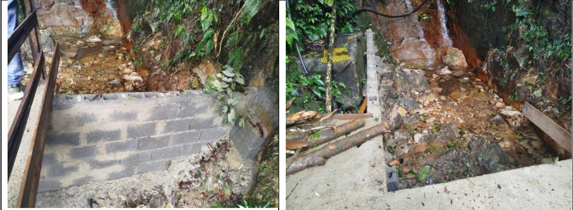
Figura 3. Muro transversal en la Q. La Rosario.
