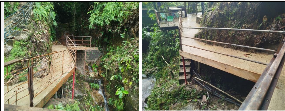
Figura 1 y 2. Sendero peatonal en concreto construido, el cual confluye a la Q. La Rosario. Fuente: Cornare.
