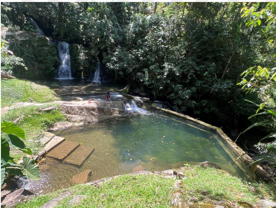
Foto 9. Obra de ocupación de cauce sobre fuente denominada Guayaban ubicada en el predio La Duquesa
