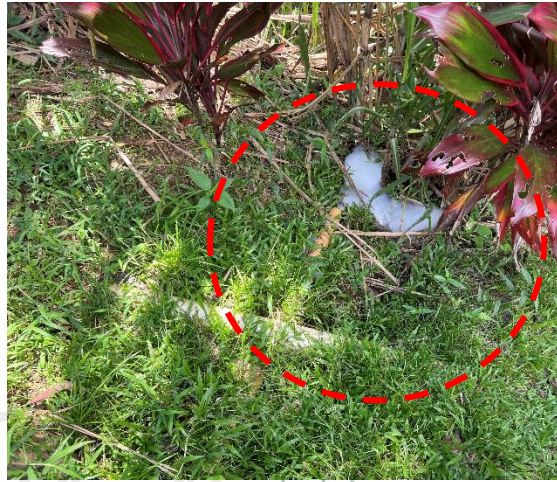
Foto 8. Salida de aguas residuales proveniente de zona de ropas sin tratamiento previo.
