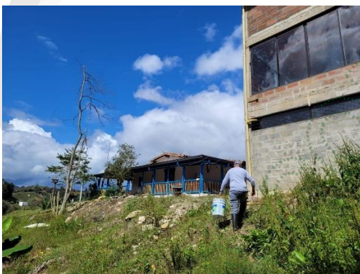
Figura 5. Vivienda rural existente
