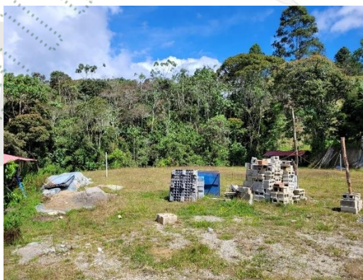
Figura 6. Área para la construcción del Galpón #2
