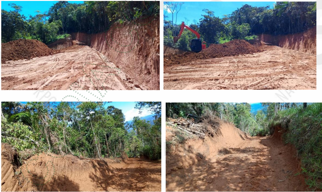
Apertura de vía.
