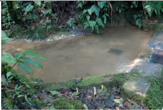
Punto de ubicación de la bocatoma acueducto La Piñuela, parte superior de la descarga de los sedimentos.
