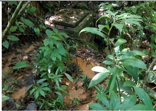
Punto aguas abajo de la bocatoma, descarga de sedimentos (lodos) provenientes de la apertura de la vía
