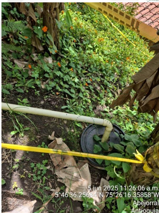
Imagen 7. Pozo de desactivación 1
