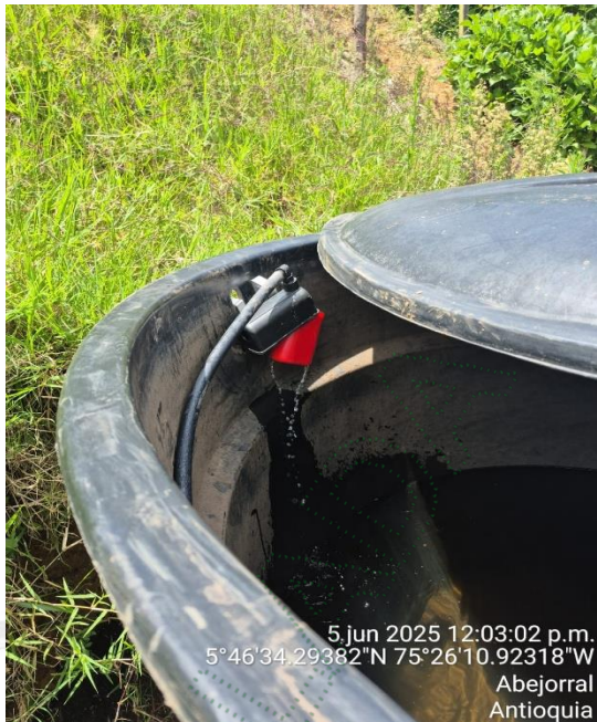
Imagen 1. Obra de captación y control de caudal. Imagen 2. Tanque de almacenamiento 1 con dispositivo de control de flujo.
