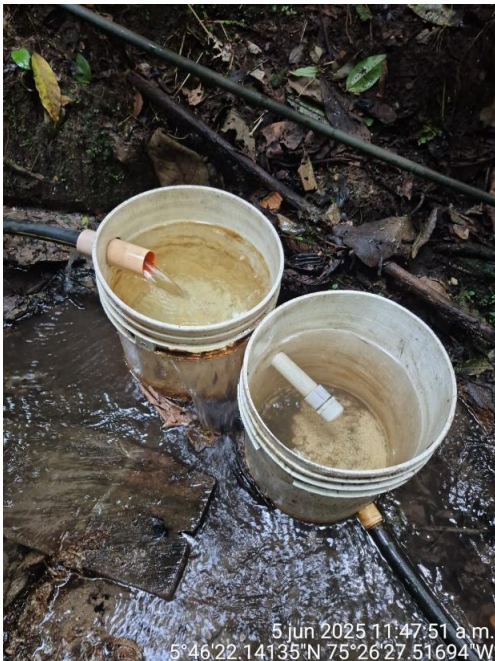
Imagen 1. Obra de captación y control de caudal. Imagen 2. Tanque de almacenamiento 1 con dispositivo de control de flujo.
