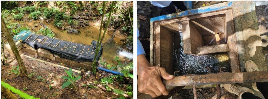
Figura 6. Desarenador y tanque de quietamiento
