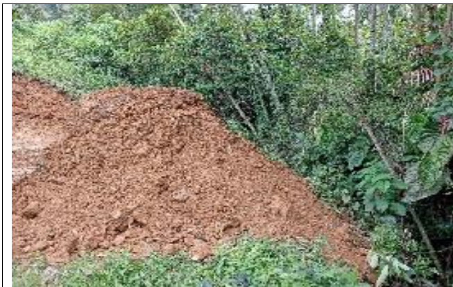
Imagen 2. Área primer movimiento de tierra. Fuente: IT-02512-2023 del 03 de mayo de 2023.
