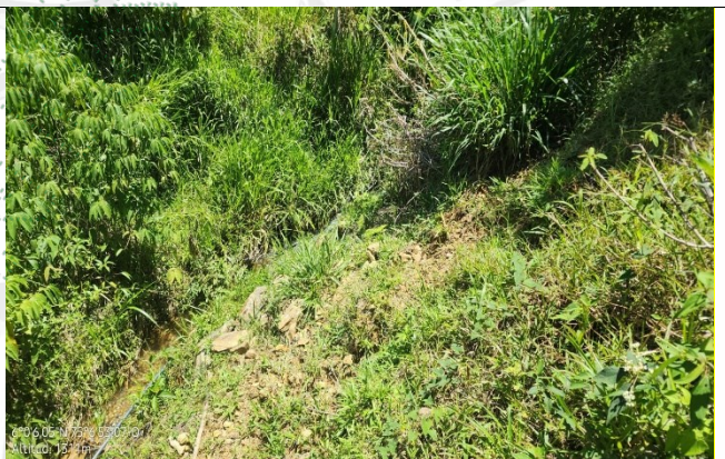
Imagen 5. Área segundo movimiento de tierra. Fuente: Visita de control y seguimiento Cornare 2025
