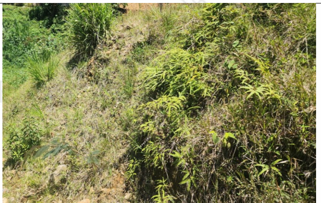
Imagen 7. Área tercer movimiento de tierra. Fuente: Visita de control y seguimiento Cornare 2025
