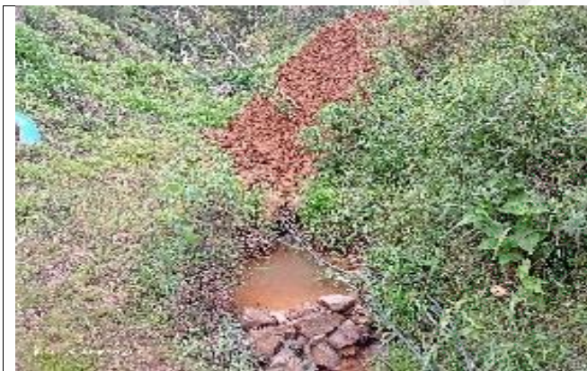
Imagen 4. Área segundo movimiento de tierra. Fuente: IT-02512-2023 del 03 de mayo de 2023
