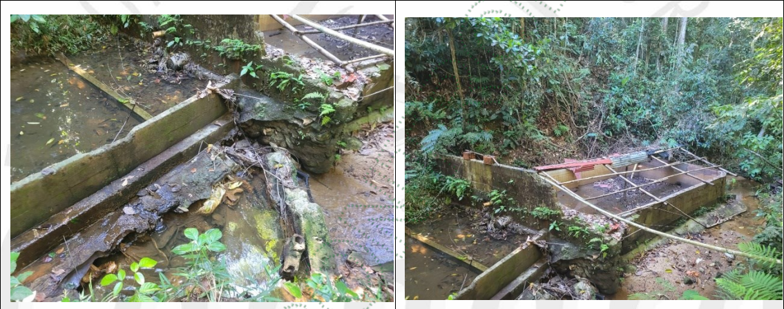
Obra de captación y tanque de almacenamiento en mampostería sobre el cauce, visita de control y seguimiento (09 de mayo de 2025)
