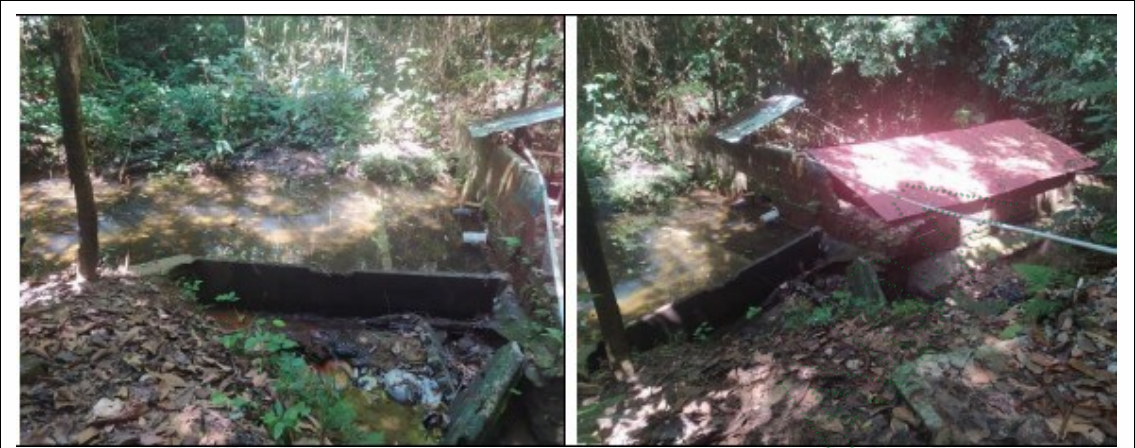
Obra de captación y tanque de almacenamiento en mampostería sobre el cauce, atención de queja ambiental (15 de diciembre de 2023)
