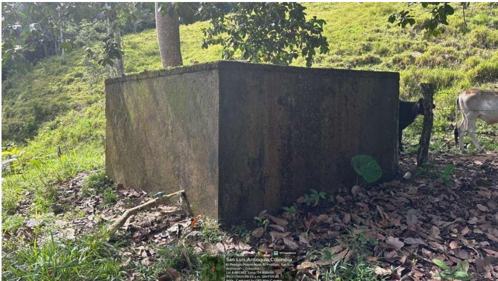
Imagen 2: Tanque almacenamiento Junta Administradora de Acueducto El Prodigio
