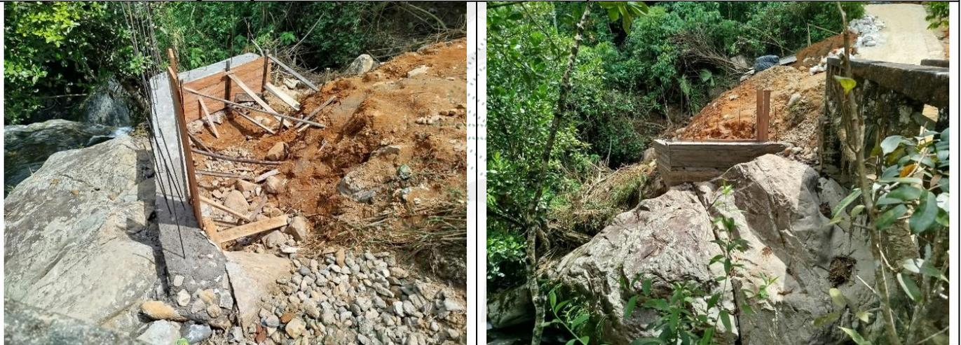
**Figura 3 y 4.** Conformación de muro en concreto ciclópeo en cauce y ronda hídrica de la Q. La Risaralda.
