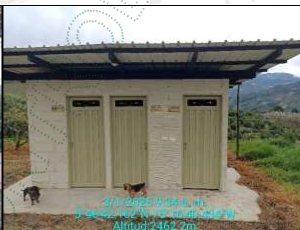
Unidad sanitaria trabajadores
