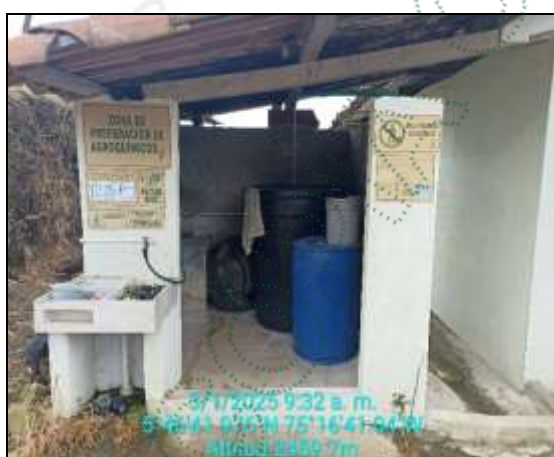
Punto preparación de mezclas
