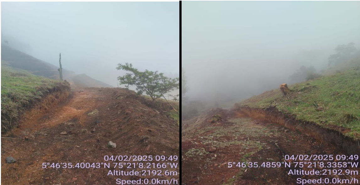
Imagen 5. Apertura de vía.
