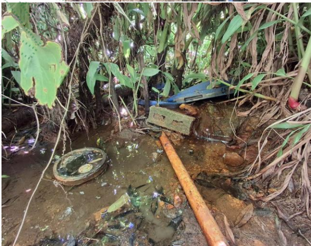
Imagen 2. Captación fuente Nacimiento Imagen 3. Captación Fuente Alto Bonito
