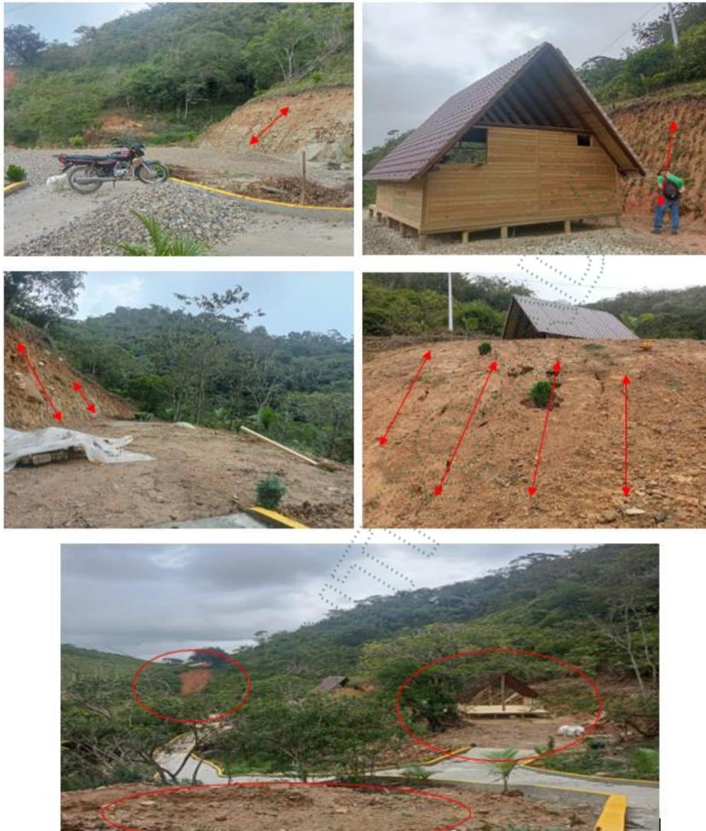
Imagen 5: Taludes cortados y movimientos de tierra - fuente: Imágenes tomadas por funcionarios cornare el día de la visita
