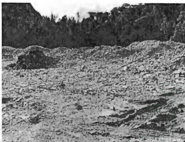
Fotografía 7. Acopio de materiales Fuente: Radicado CE-12351-2024, ICA 2024-I
