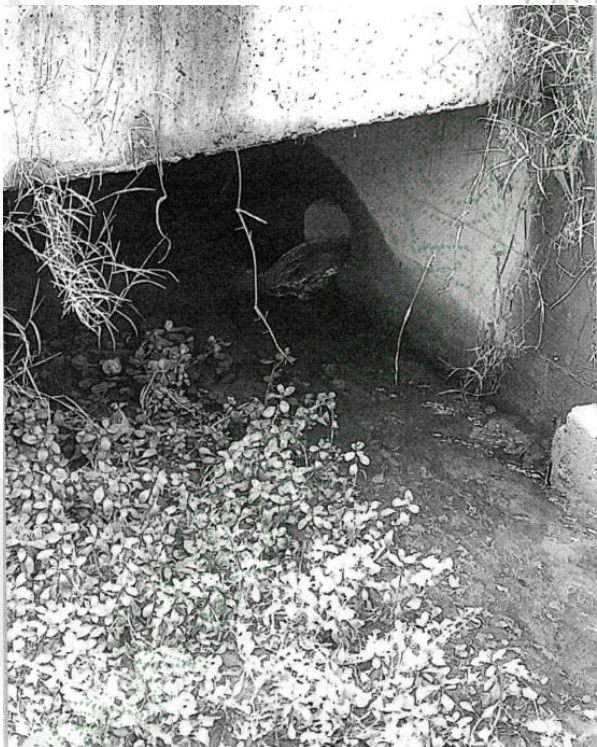
Estructura de descarga implementada
