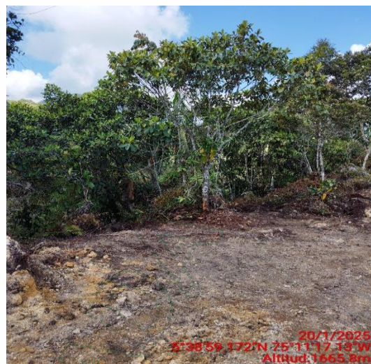
Área final de la apertura de vía
