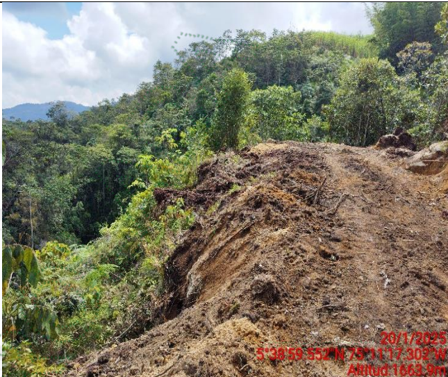
Apertura de vía
