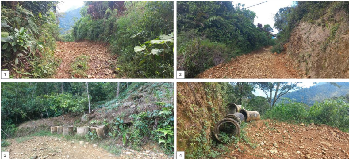
Imagen 1 y 2 Apertura de vía. Imagen 3 y 4 Atanores de concreto Fuente: Cornare, 2024
