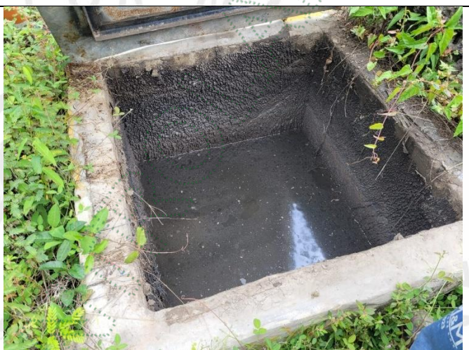
Figura 5. Tanques sedimentadores
