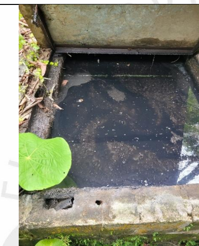
Figura 3. Cárcamos de recolección de las aguas residuales no domésticas
