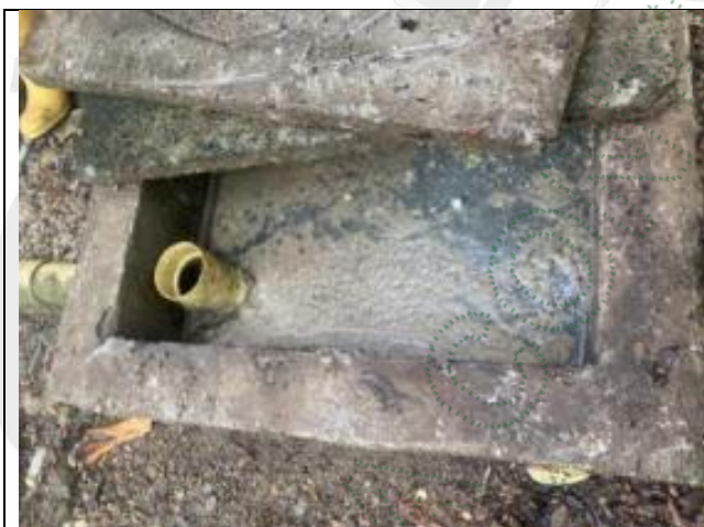
Figura 1. Estado actual Pretratamiento Trampa de grasas
