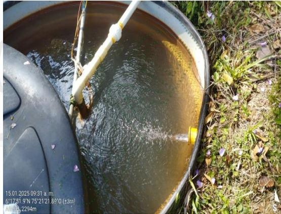
Imagen 1. Obra de Captación, derivación y control de caudal de captación.
