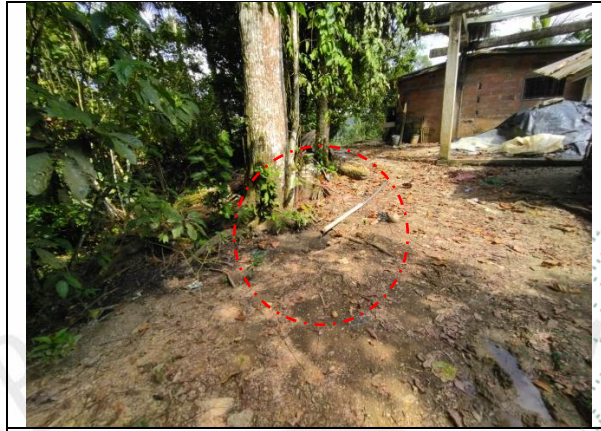
Imagen 7. Tubería de descarga de las aguas residuales domésticas sin tratamiento previo
