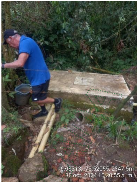
Imagen 4. Tanque de almacenamiento
